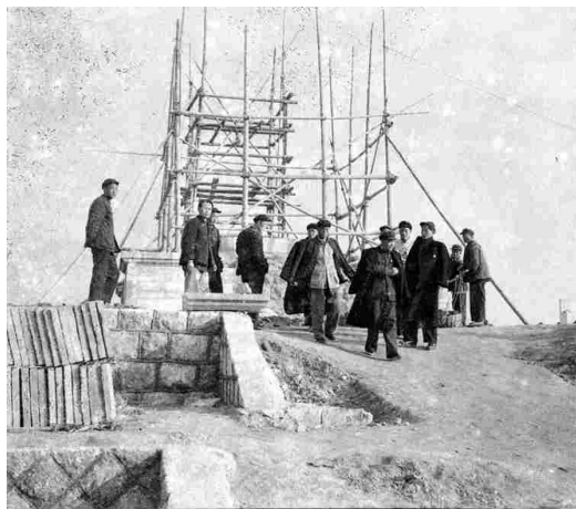
碾庄烈士纪念碑建设工地
